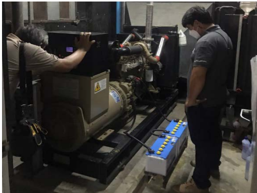
ตรวจสอบเครื่องไฟฟ้าสำรอง
